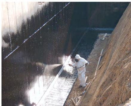
DERMARUBBER S/P: sequenza applicazione a spruzzo su muro di fondazione
